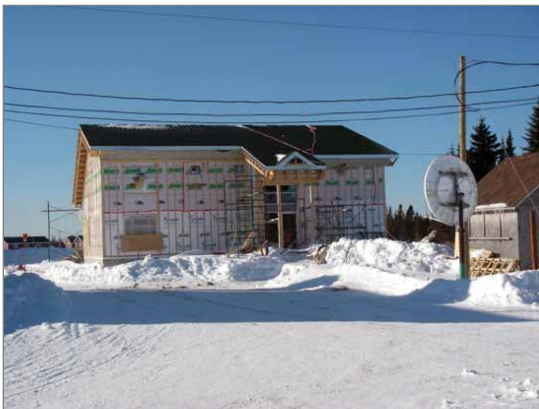
Photo 39-2 : Maison des jeunes d'Ekuanitshit (en construction en mars 2007)
