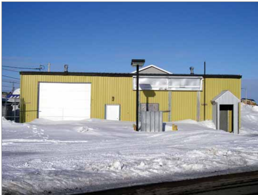
Photo 41-3 : Usine de délardage de peaux de phoque construite en 2004 (avril 2007)
